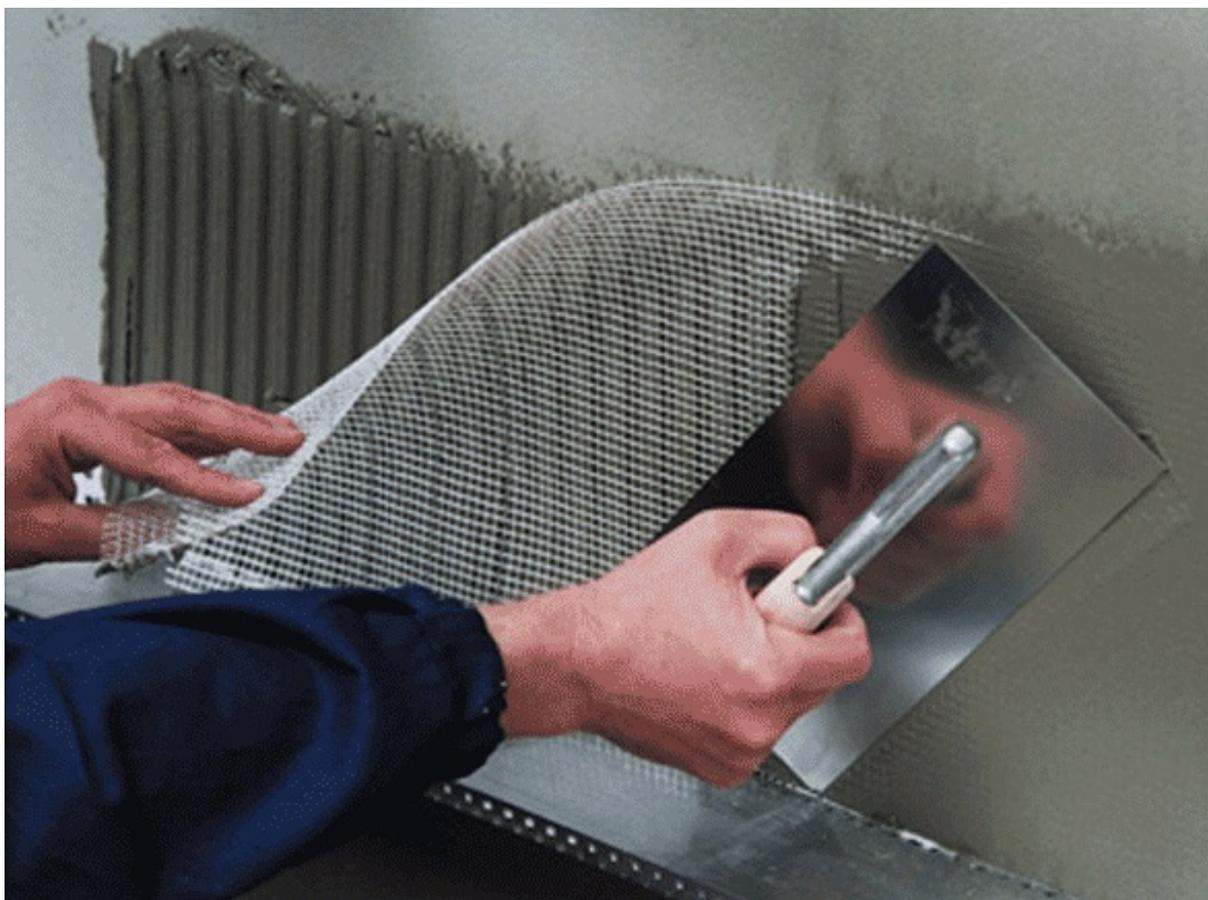
Рис. 20. Крепление армирующей сетки к утеплителю.
