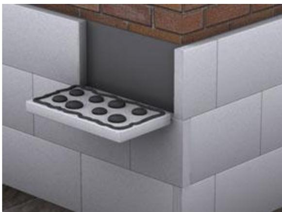
Рис. 14. Наклейка утеплителя на стену
