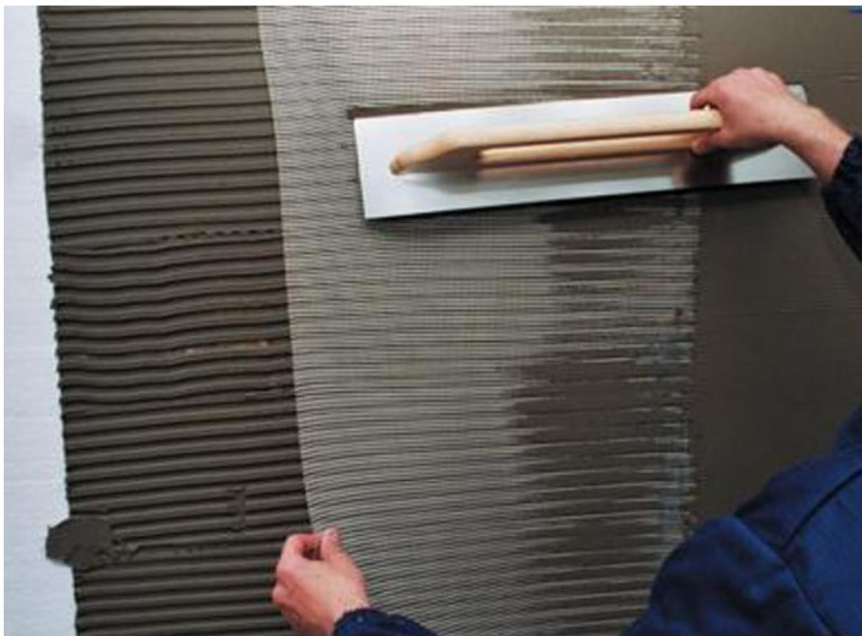
Рис. 21. Крепление армирующей сетки к утеплителю.
