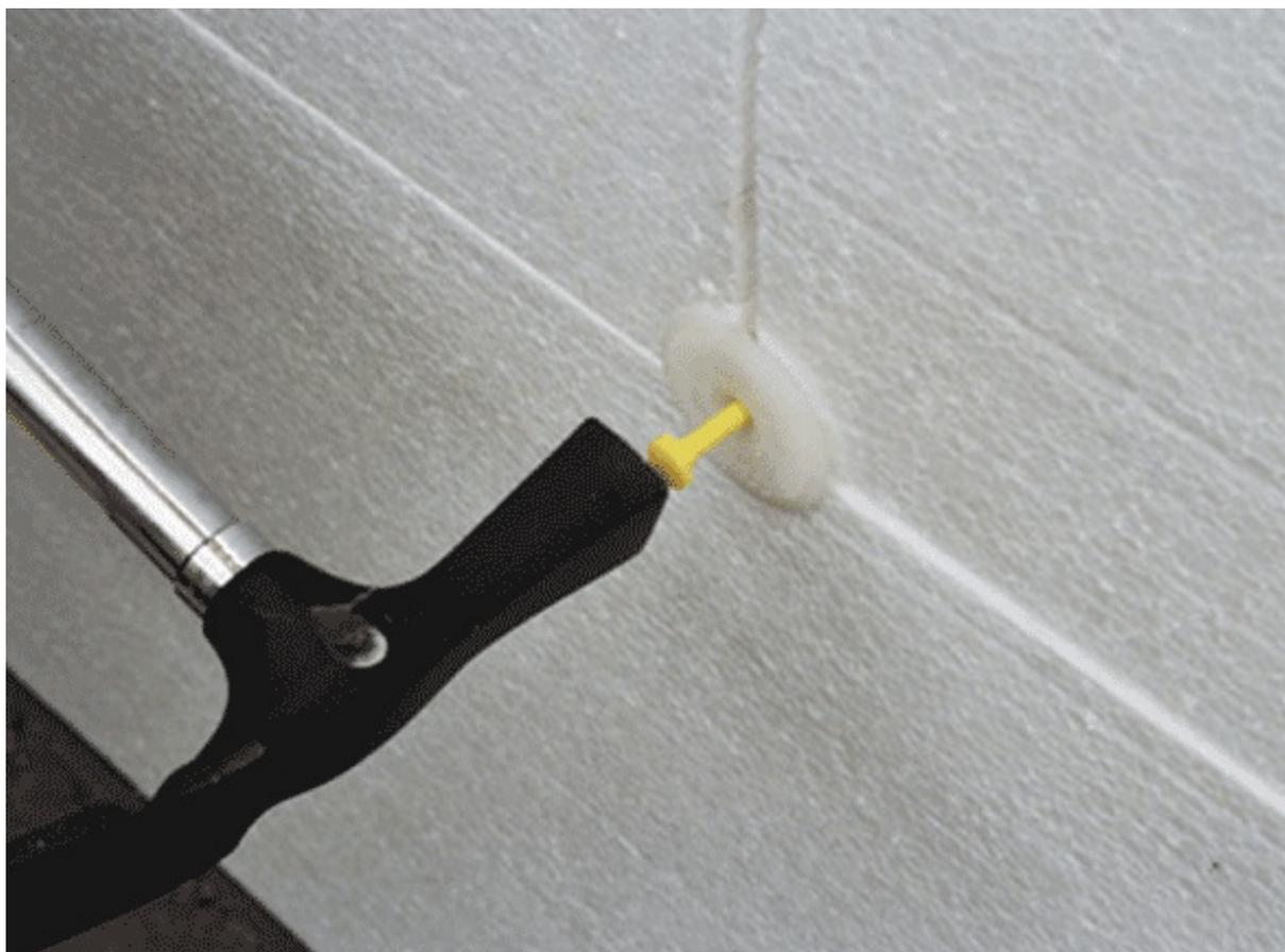
Рис. 19. Забивание распорных наконечников в дюбели
