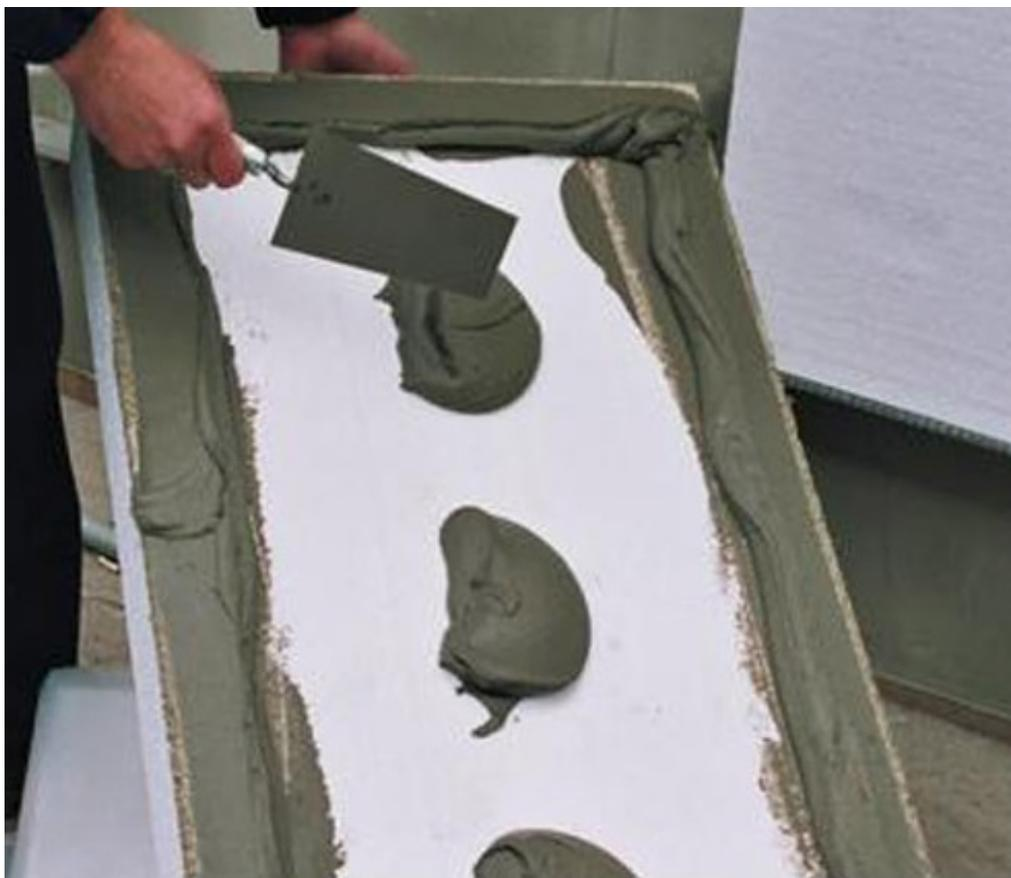
Рис. 13. Нанесение клеевой смеси на плиту утеплителя.
